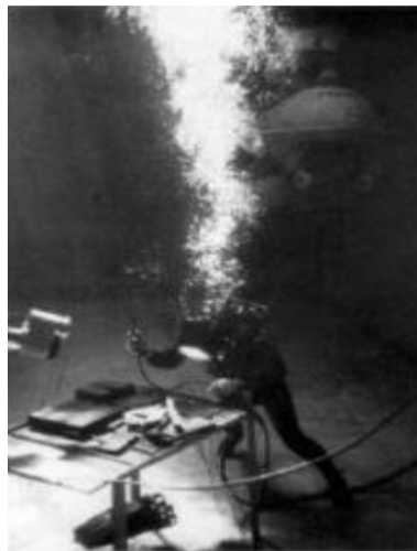
Slika 1. Prve izvedbe zavarivanja pod vodom [2]
