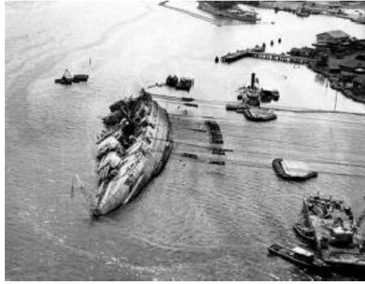
Slika 2. Popravak broda u luci Pearl Harbour [4]
