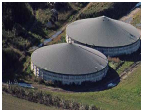
Slika 2.37. Spremišta digestata prekrivena membranom
