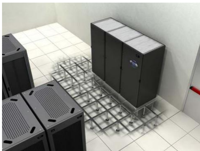
Slika 22. Prikaz „downflow down“ tip jedinice u prostoru [3]
