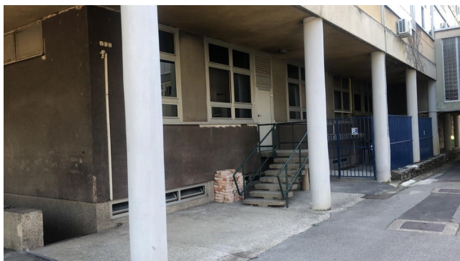
Slika 12. Postojeće stanje sjevero-istočnog pročelja niskog prizemlja
