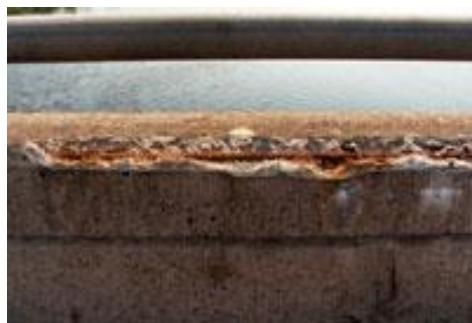
**Slika 13. Korozija čelične armature u betonu [20]**
