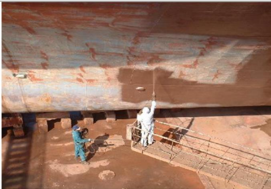
Slika 1. Nanošenje temeljnog premaza bezračnom metodom[5]
