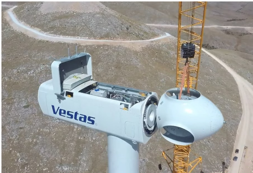
Slika 2.6. Montaža glave rotora na gondolu [8]
