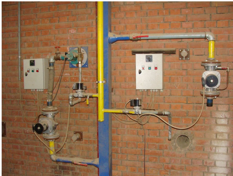
Slika 60. Demontaža bočnih HG plamenika
