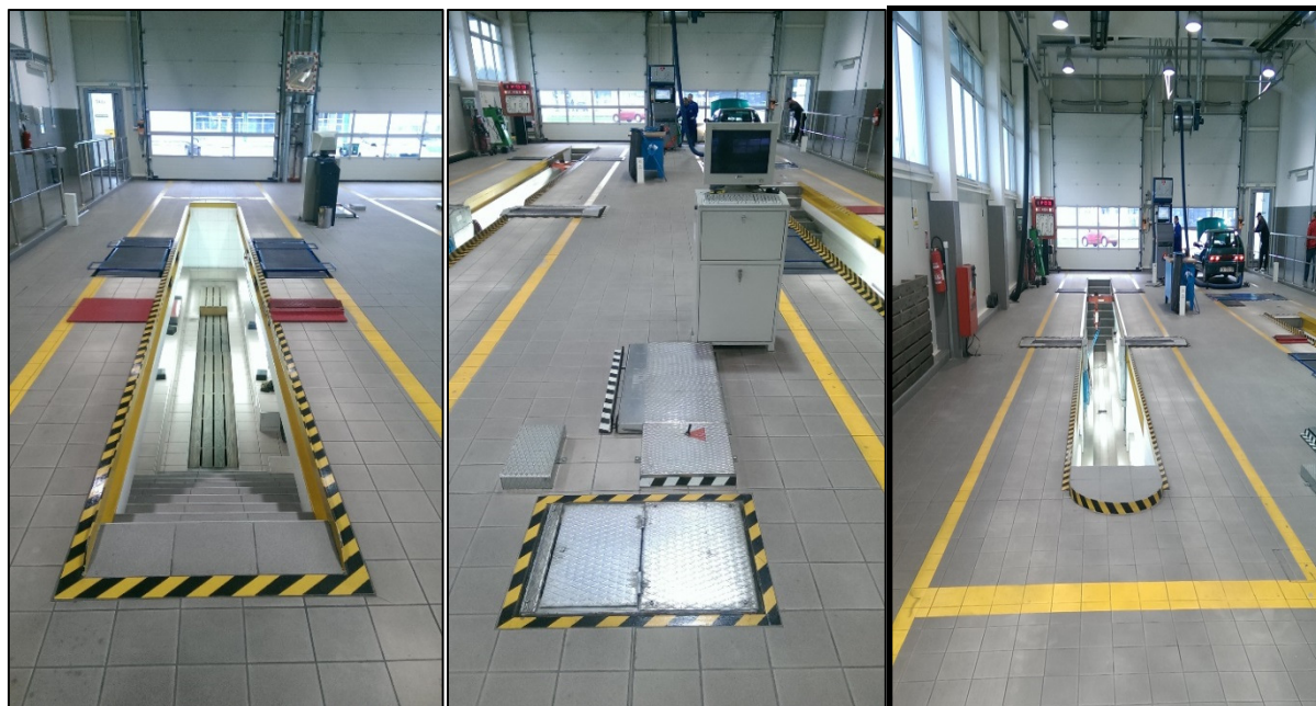
Slika 20. Žute i žuto-crne linije koje označavaju radni prostor, uređaje i kanal na TL
