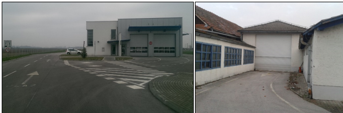
Slika 6. Izlazna strana nove i stare STP
