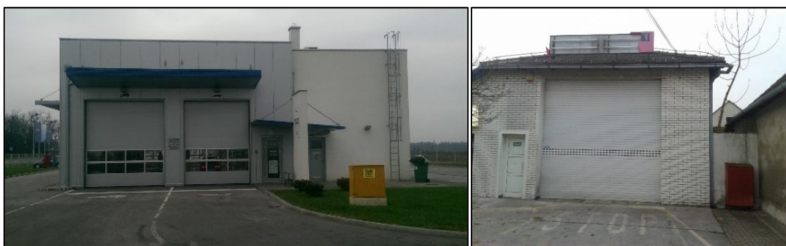
Slika 4. Ulazne strane nove i stare STP
