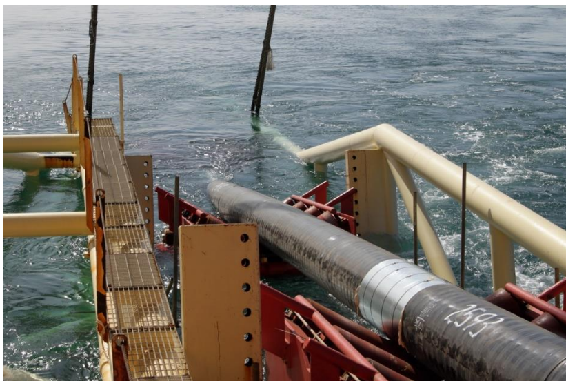
Slika 4.21 Polaganje odobalnog plinovoda [35]
