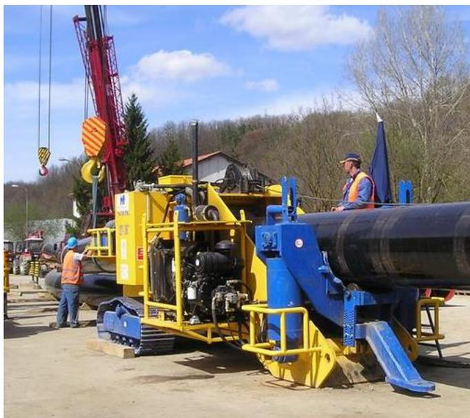
Slika 6.1 Savijanje cijevi DN 800 [33]
