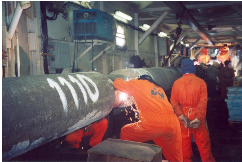
Slika 4.22 Tunnel na cjevopolagaču za zavarivanje plinovoda Platforma Ivana K – Pula [35]
