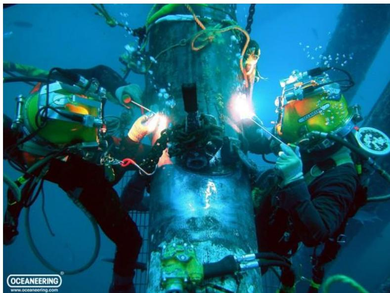
Slika 4.17 Mokro podvodno zavarivanje [69]
