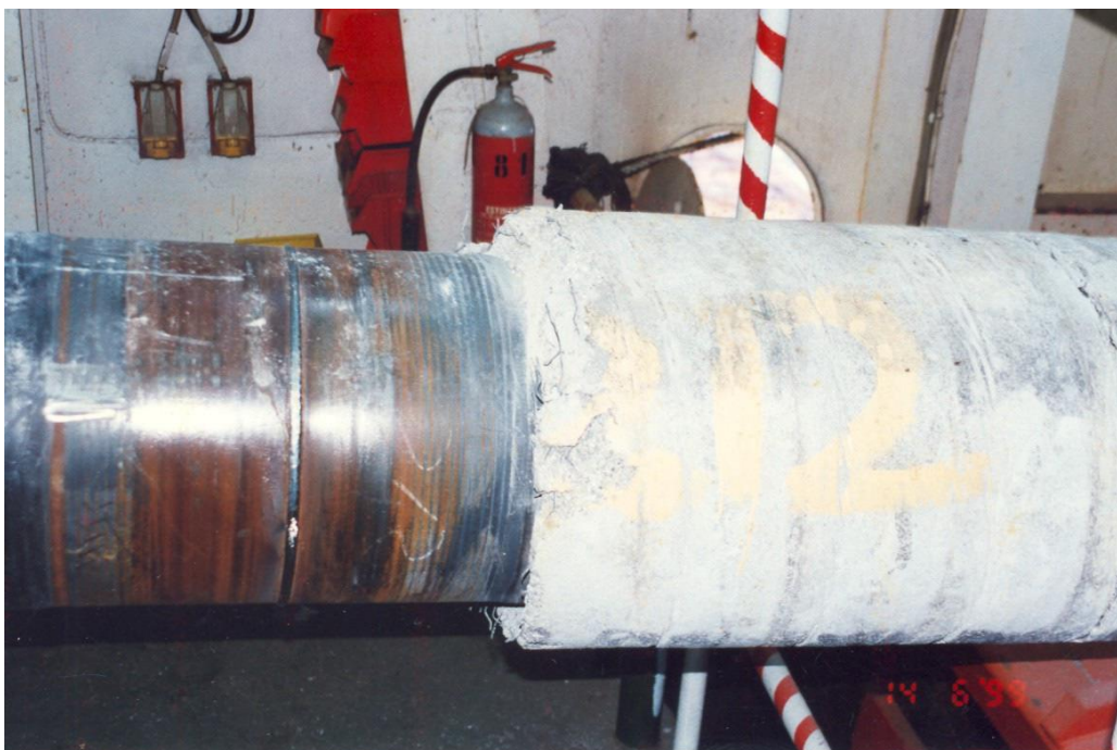
Slika 4.11 Plinovod Platforma Ivana A – Platforma Garibaldi K (očišćeni zavareni spoj prije izoliranja) [35]
