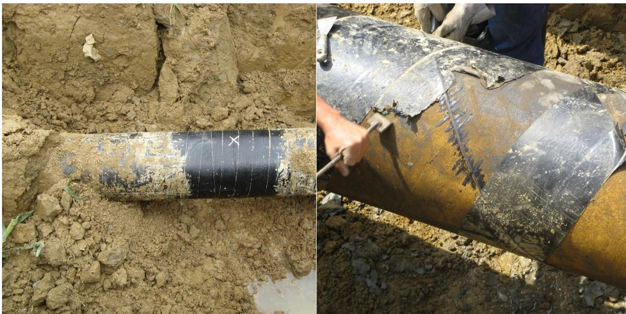
Slika 9.14 Iskopano mjesto oštećenja i skidanje izolacije [33]
