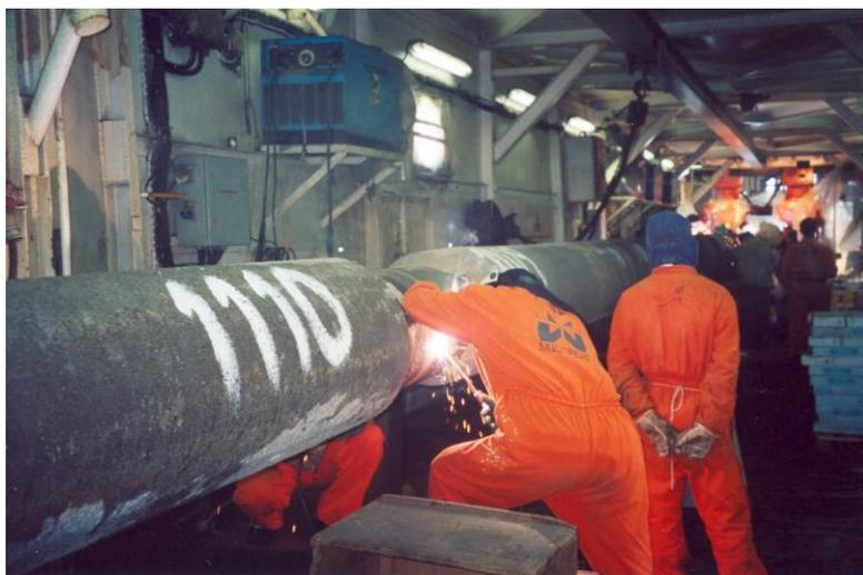
Slika 4.22 Tunel na cjevopolagaču za zavarivanje plinovoda Platforma Ivana K – Pula [35]
