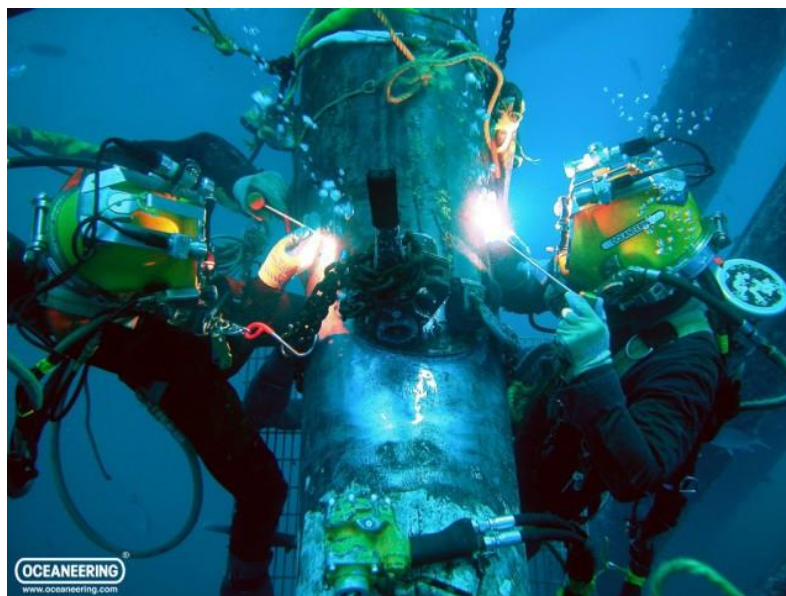
Slika 4.17 Mokro podvodno zavarivanje [69]
