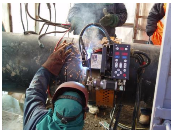
Slika 7.5 Glava za zavarivanje [35]
