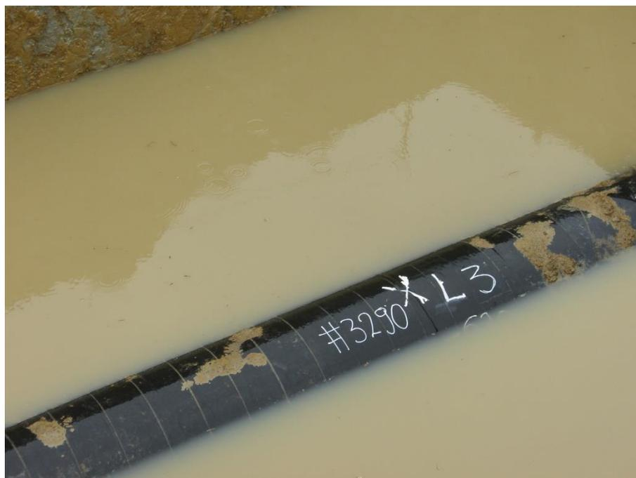
**Slika 9.9** Punjenje iskopanih rovova vodom zaostalom u okolnom tlu nakon višednevnih kišnih dana [33]
