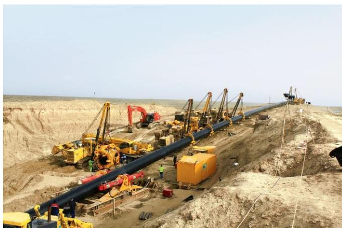
**Slika 3.15 Ulaz u horizontalno usmjerenu bušotinu [67]**
