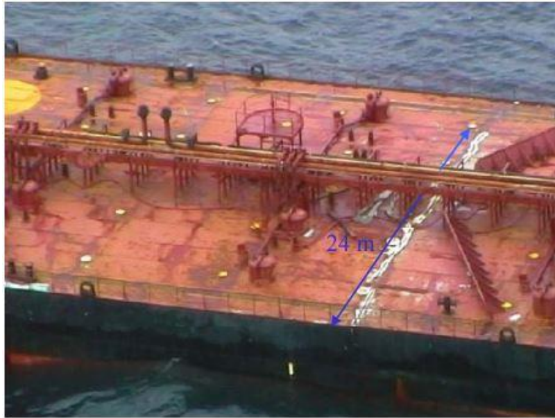
Slika 4.4 Pukotina preko palube tankera Castor[118]
