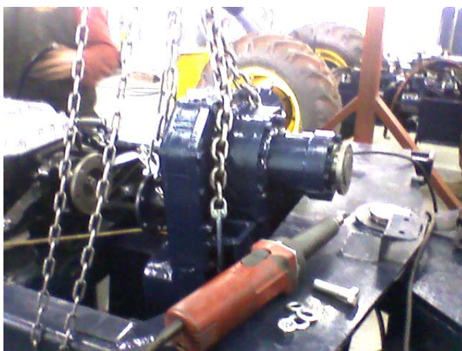
Slika 81: Motaža razvodnika pogona
