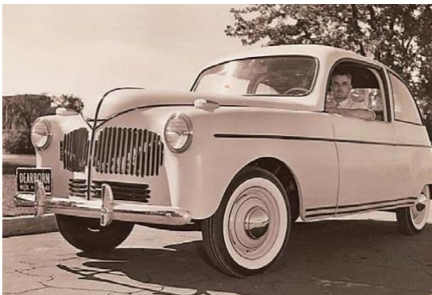
Slika 24. Fordov automobil od duromernog kompozita s konopljom [15]
