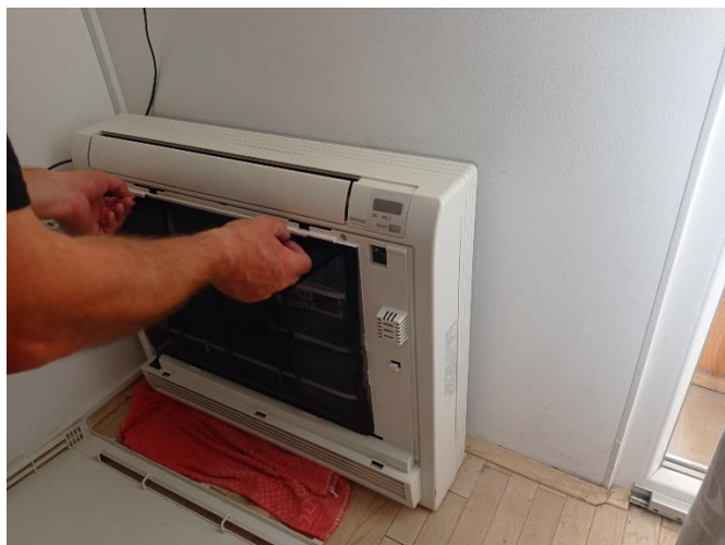
Slika 16. Skidanje maske ventilokonvektora
