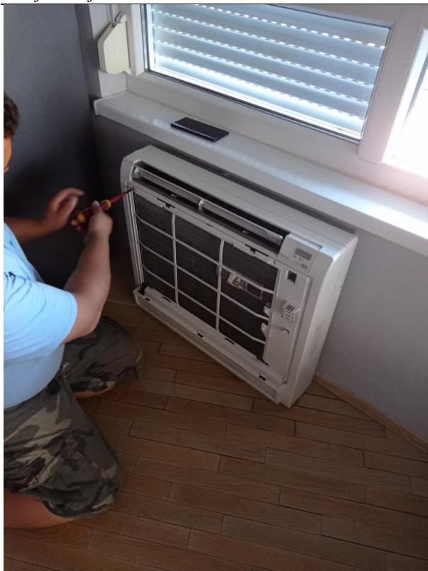
Slika 28. Skidanje maske ventilokonvektora
