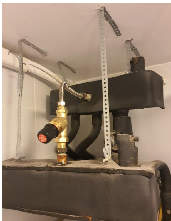
Slika 27. Ventil poslije zamjene
