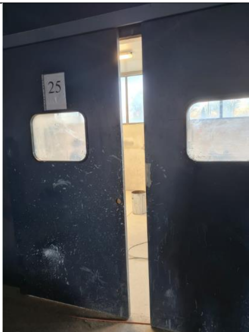
Slika 30. Vrata na ulazu u lakirnicu
