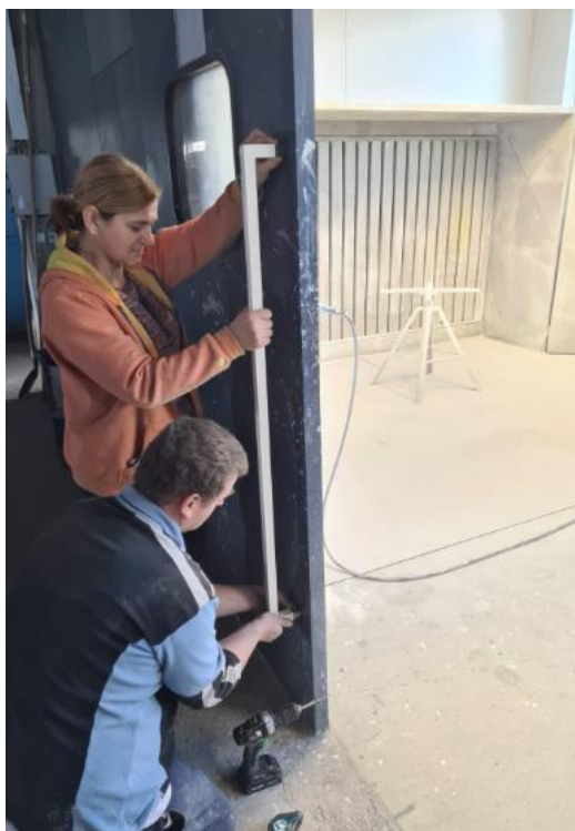
Slika 31. Montaža rukohvata na vrata lakirnice
