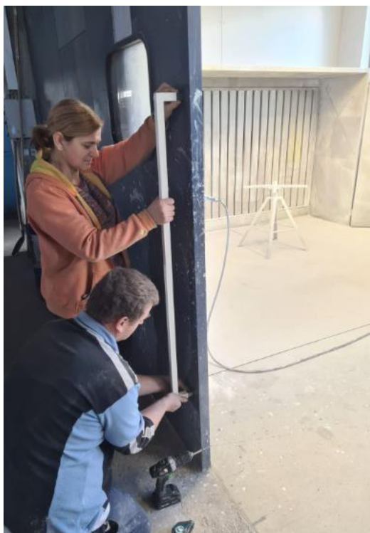
Slika 31. Montaža rukohvata na vrata lakirnice
