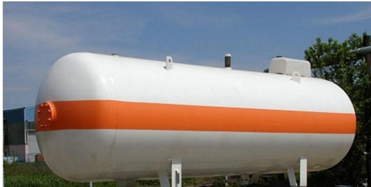
Slika 29. Spremnik za UNP (ukapljeni naftni plin) [26]
