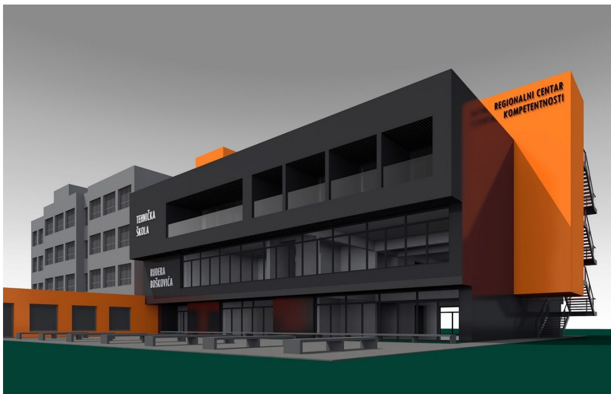
Slika 1. Analizirana zgrada Tehničke škole Ruđer Bošković [5]
