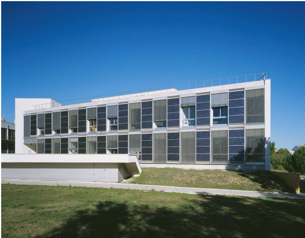
Slika 1. Primjer pasivno hlađene zgrade - Solar XXI zgrada [9]
