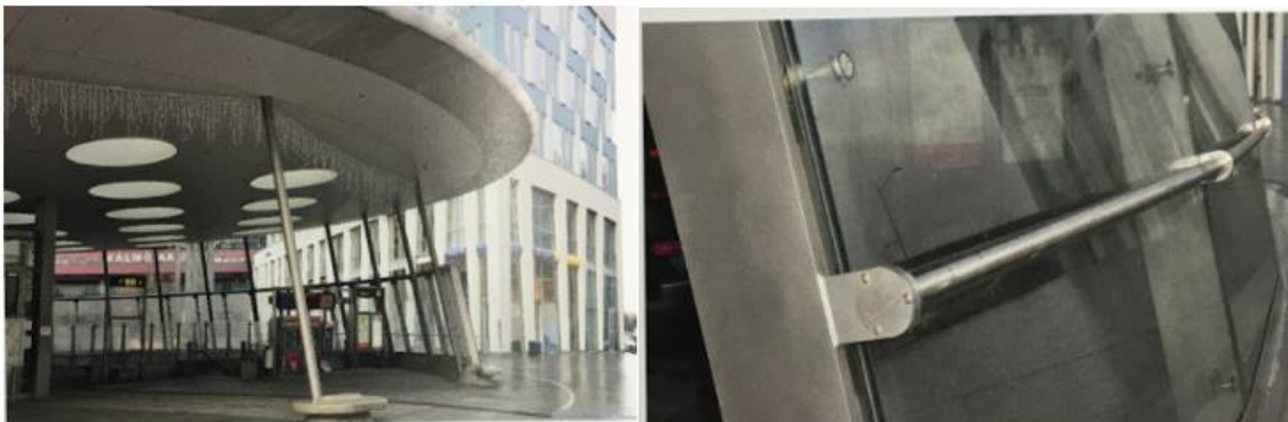
Slika 13: Stanica u Švedskoj, rukohvati od duplex nehrđajućeg čelika [29]
