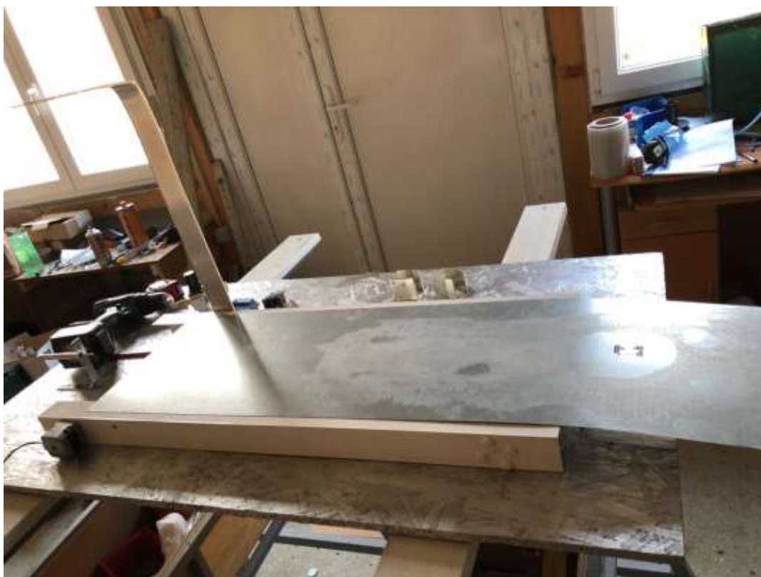
Slika 19. Postavljanje lima na stupove
