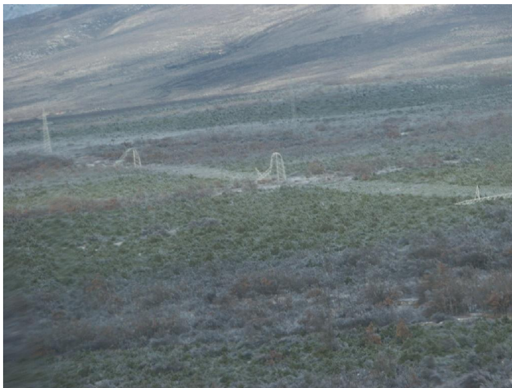
Slika 2-4-6-2 Štete na dalekovodu uslijed leda (izvor: Vjesnik Hrvatske elektroprivrede)
