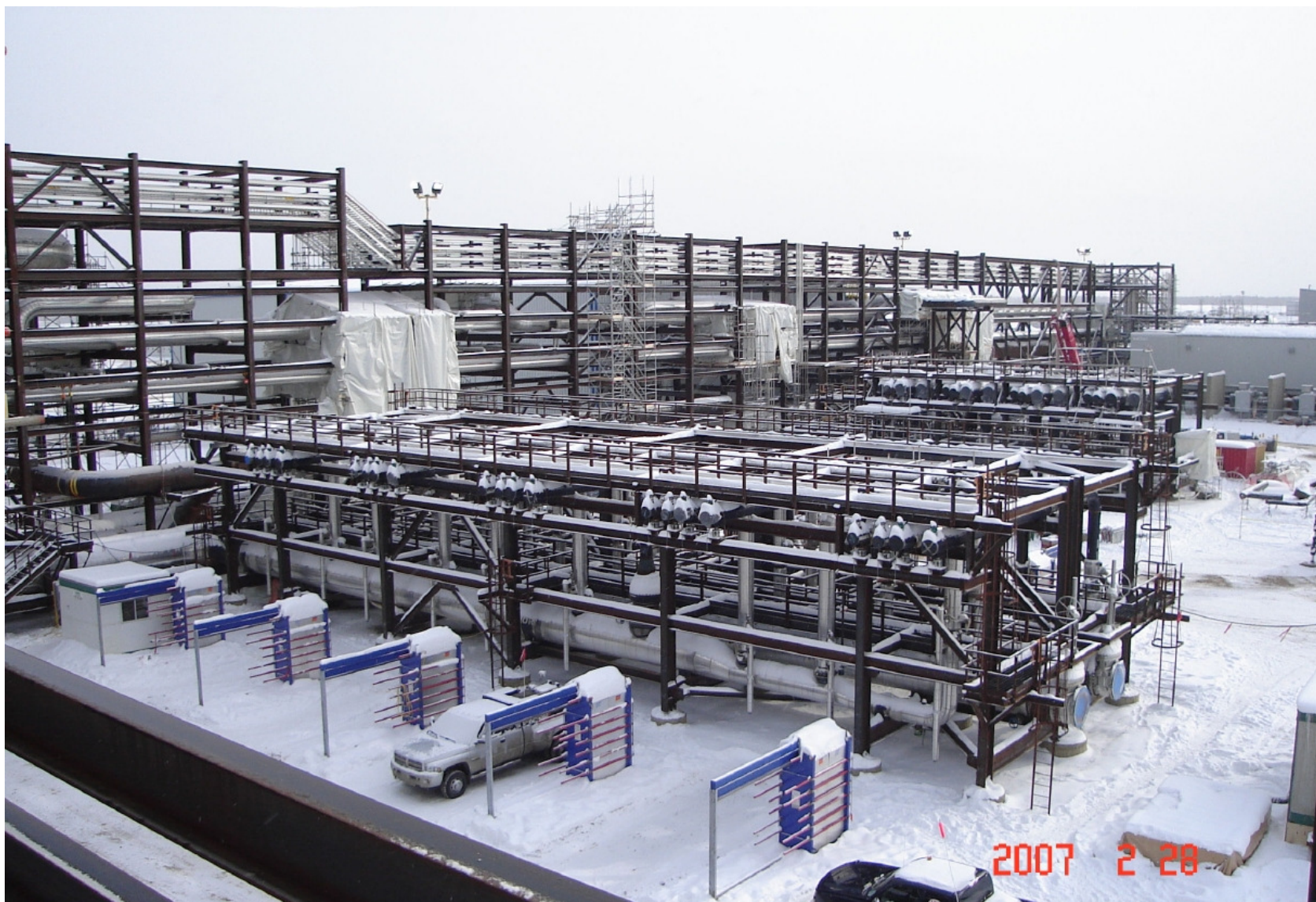
Slika 5.8. Projekt Horizon – Postrojenje H & C prije centriranja, niveliranja i povezivanja modula 4
