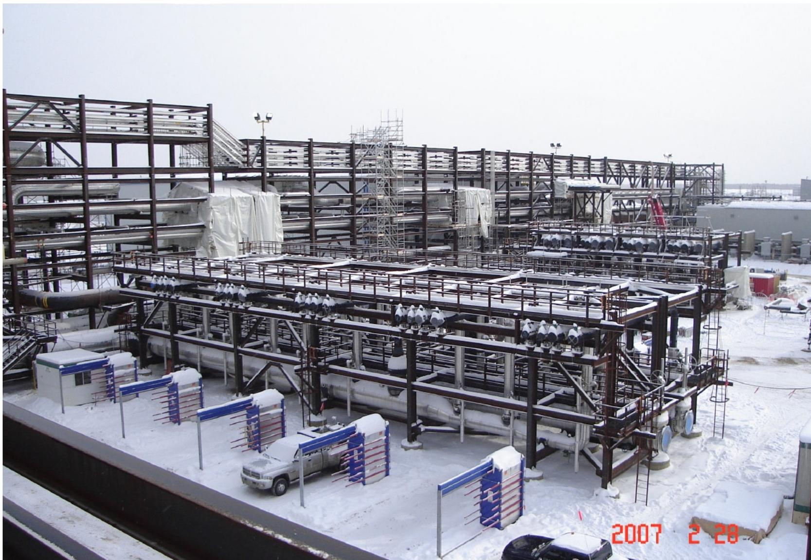
Slika 5.8. Projekt Horizon – Postrojenje H & C prije centriranja, niveliranja i povezivanja modula<sup>4</sup>
