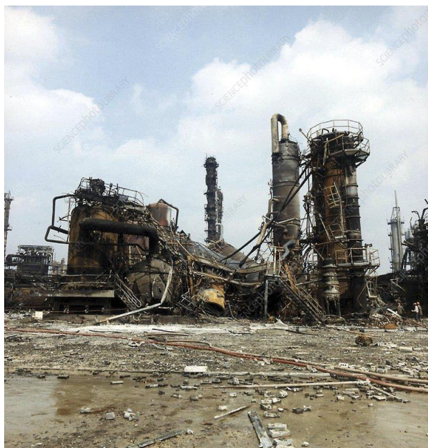
Slika 17: Šteta nastala nakon eksplozije u kemijskoj tvornici u Flixborough-u [33]
