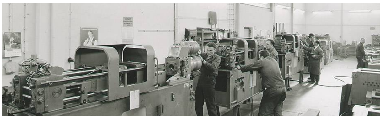
Slika 3.1. Proizvodnja ubrizgavalica Ankerwerk [20]
