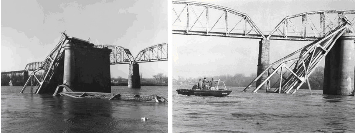
Slika 6 i 7: Urušeni most "Silver Bridge", 1967. god. [7]
