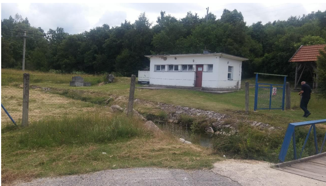
Slika 47. Crpna stanica Kraljevac
