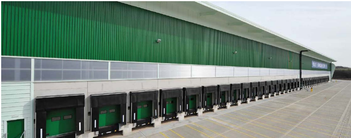
Slika 15. Prikaz utovarno istovarne zone i nakon izgradnje skladišta
