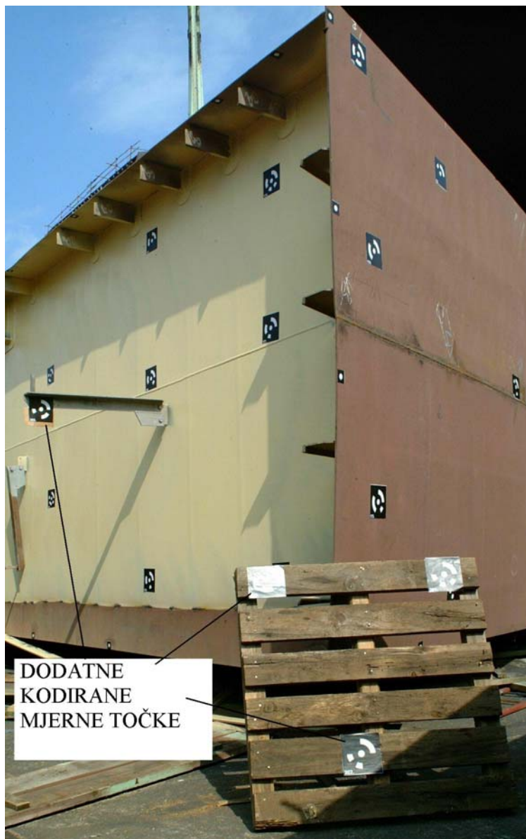
Slika 46: Postavljanje dodatnih mjernih točaka
