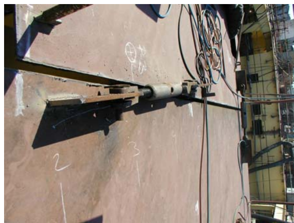
Slika 25: Mehanički pritezač za pozicioniranje sekcije
