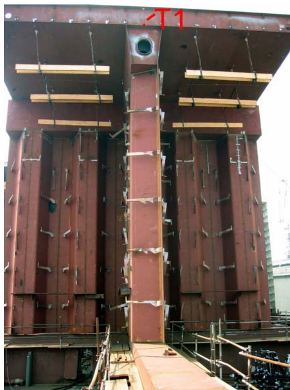
Slika 31: Postavljanje mjerne točke u simetralu sekcije
