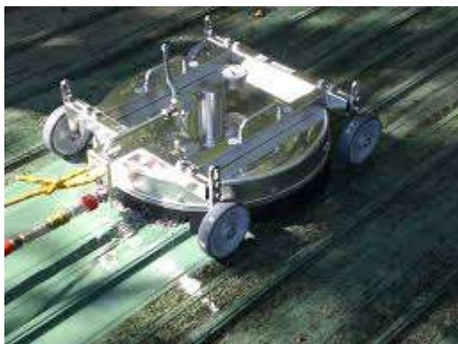
Slika 36. Mosmatic uređaj na limenom pokrovu [18]
