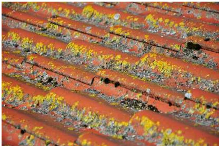
**Slika 6. Mahovina, lišajevi i nečistoće na glinenom krovu [4]**
