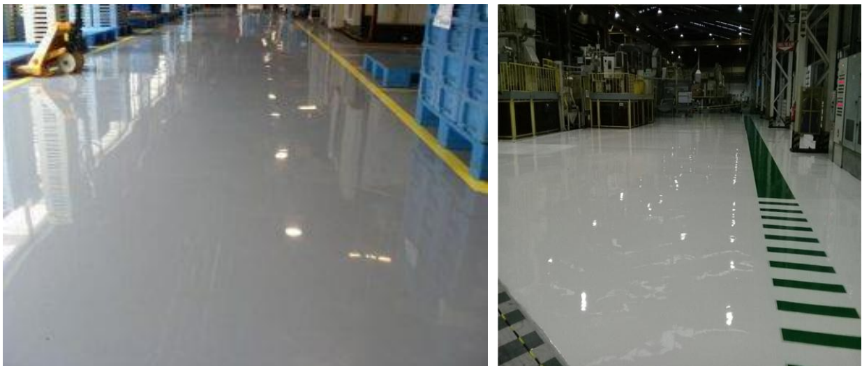
Slika 5.6. Tekući epoksidni premaz [18, 19]
