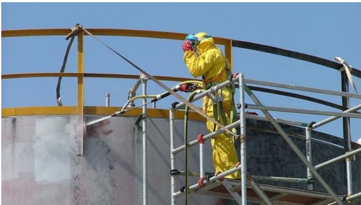
Slika 1.1. Zaštita čeličnih konstrukcija organskim premazima [3]
