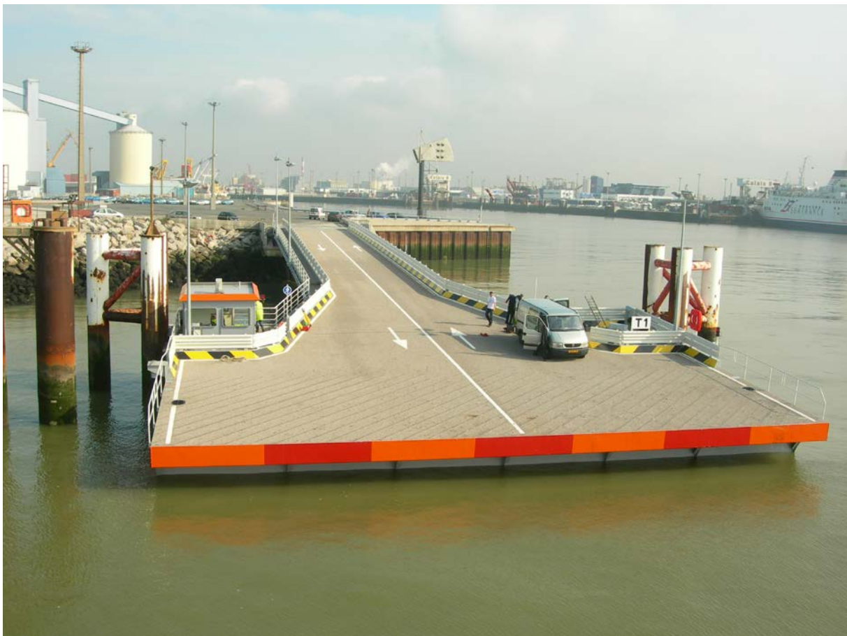
Slika 1. Linkspan u luci grada Calais
