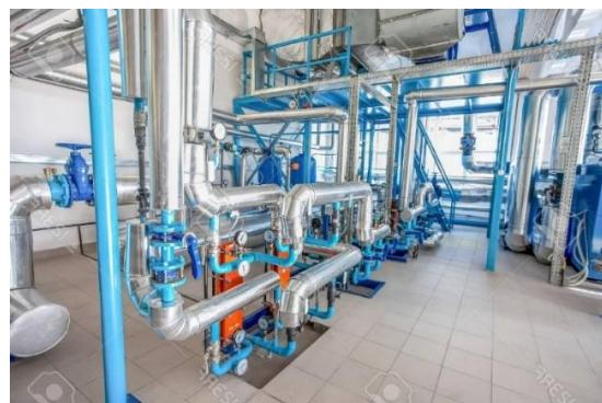
Slika 1. Cjevovod izrađen od nehrđajućeg čelika [3]
