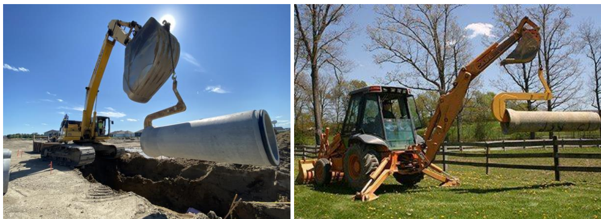
Slika 16. Primjeri korištenja samobalansirajuće kuke Kenco [12]
