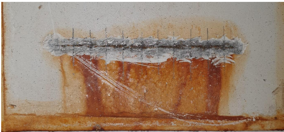
Slika 47. Ocjenjivanje stupnja korozije oko ureza
