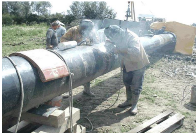
Slika 30. REL zavarivanje cjevovoda celuloznom elektrodom (silazna tehnika) [15]
