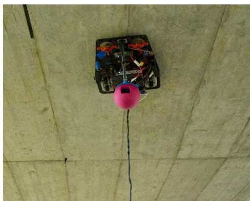
Slika 15. Inspekcija pomoću robota [17]
