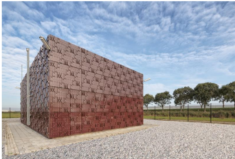
Slika 9.9. Fasada stanice za prihvat plina [80]
