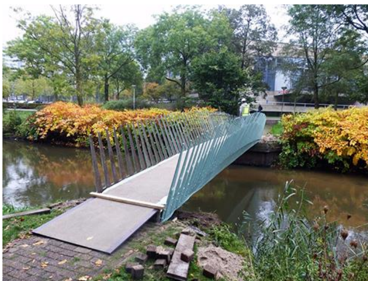
Slika 9.12. Pješački most od prirodnih kompozita [81]
