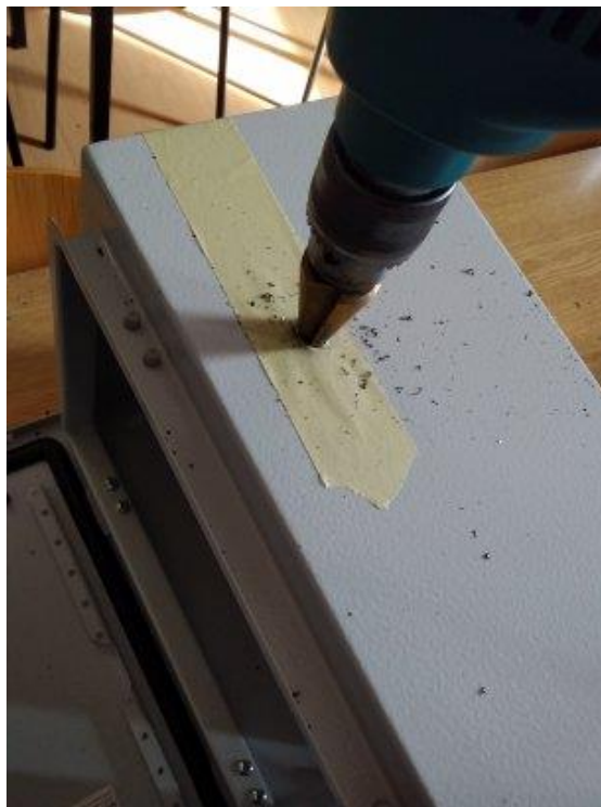
Slika 30. Bušenje razvodnog ormara
