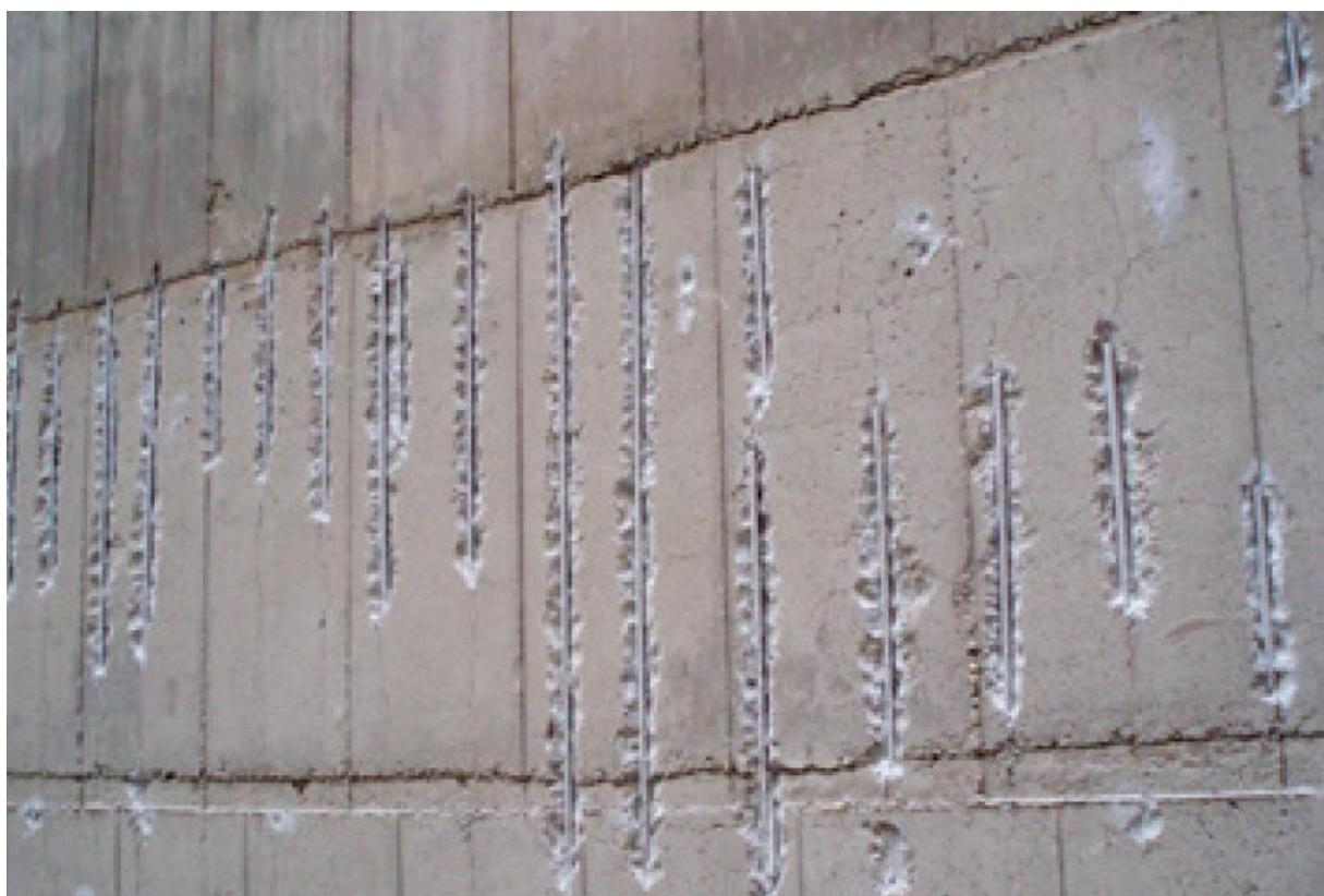
Slika 8. Korodiranje čelične armature betonskih dimovoda [12]
