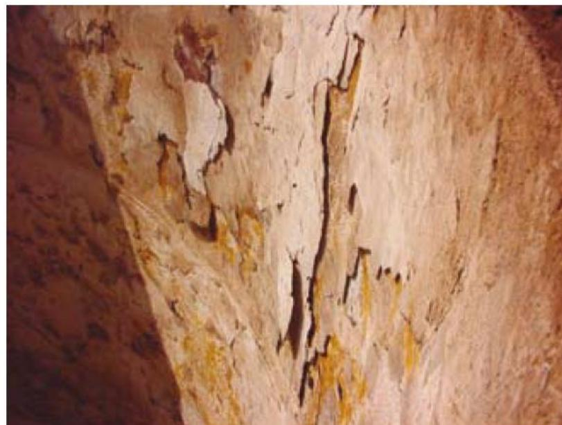
**Slika 10. Unutrašnjost čeličnog dimovoda oštećenog korozijom [13]**
