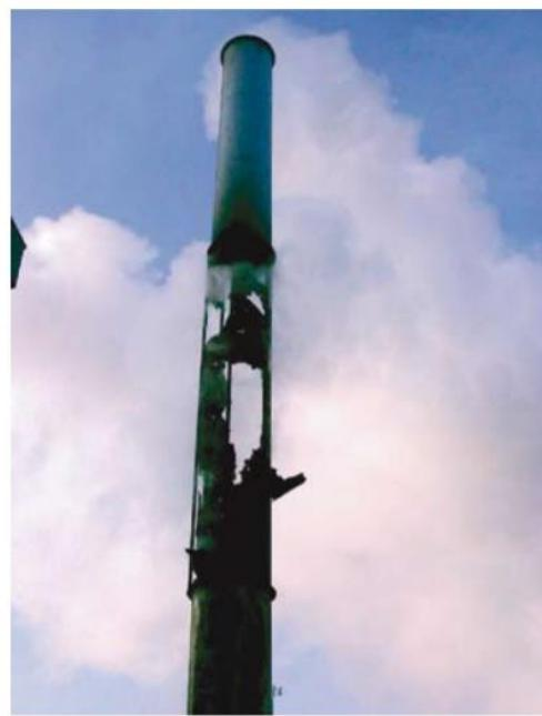
**Slika 11. Strukturno nestabilan dimovod [13]**
