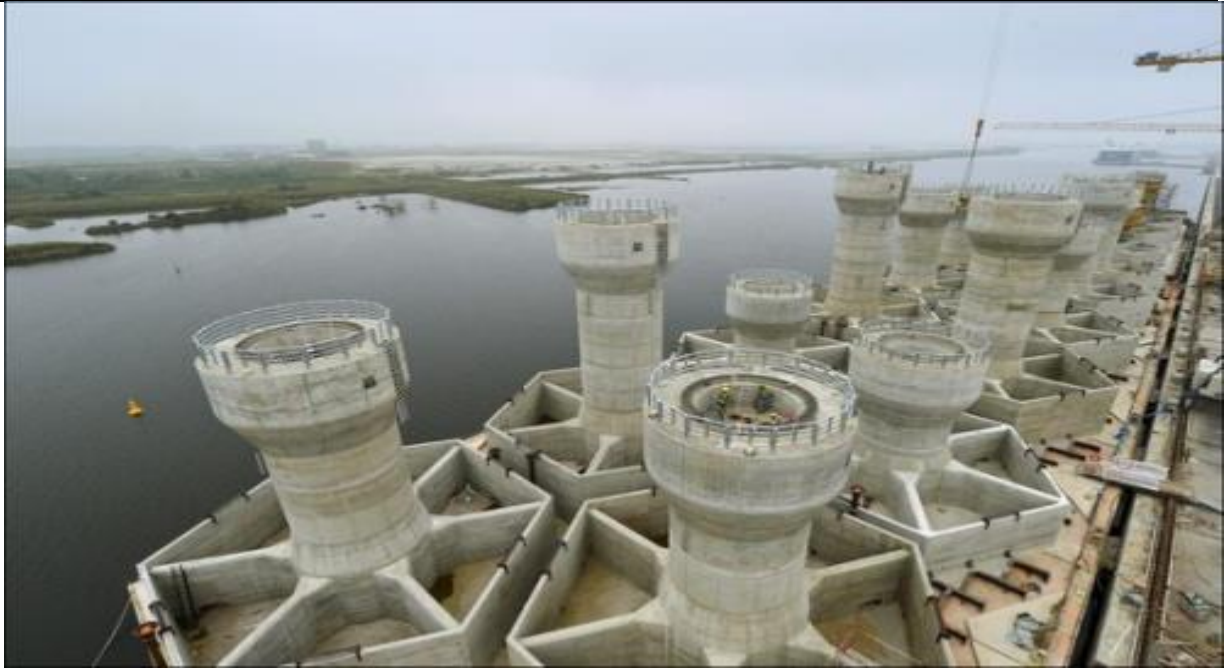
Slika 10. Primjer temelja s gravitacijskom betonskom bazom [9]
