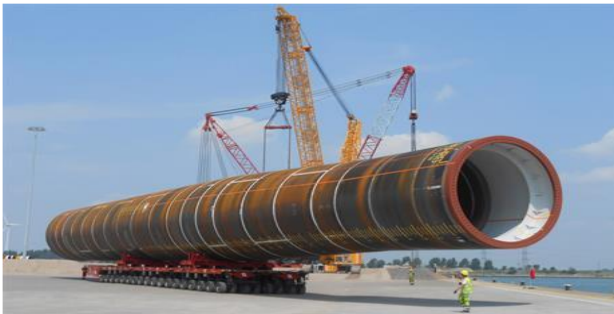
Slika 9. Primjer jednostupnih temelja [8]
