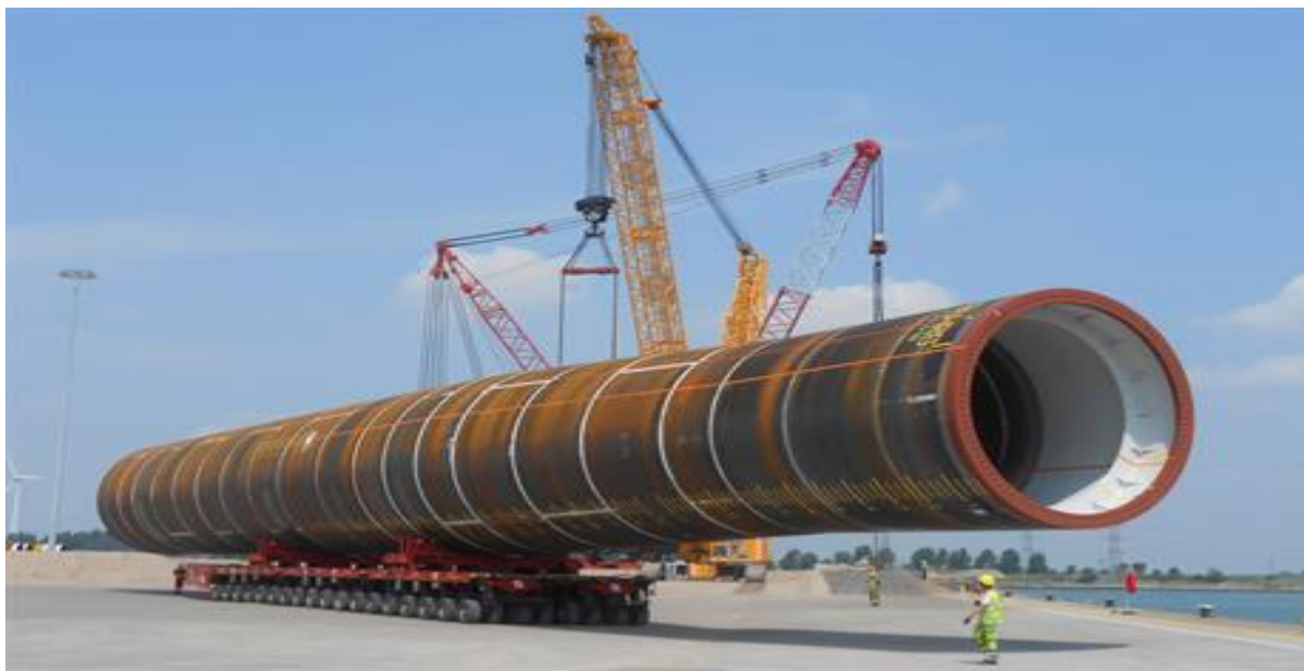
Slika 9. Primjer jednostupnih temelja [8]
