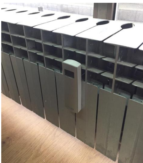
Slika 1-2 Razdjelnik troškova toplinske energije na radijatoru
