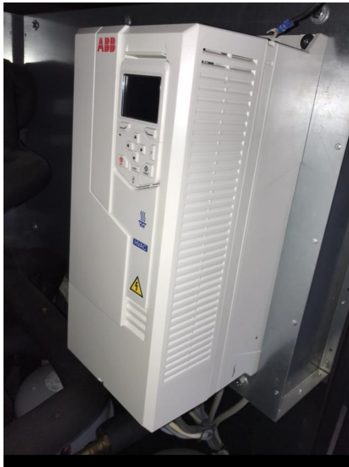
Slika 21: Frekvencijski pretvarač ABB ACH580-01
