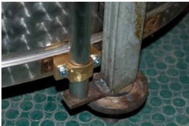
Slika 3.5: Vodilice od mjedi i cijev za vođenje
