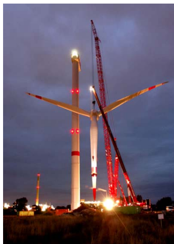
Slika 6. Montaža REpower 5MW
