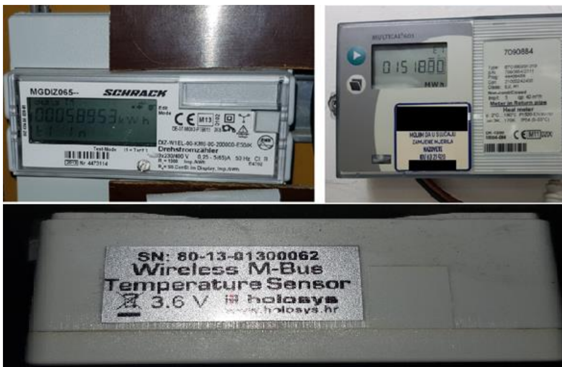
Slika 5.2 Mjerni uređaji za praćenje potrošnje energije i drugih parametara
