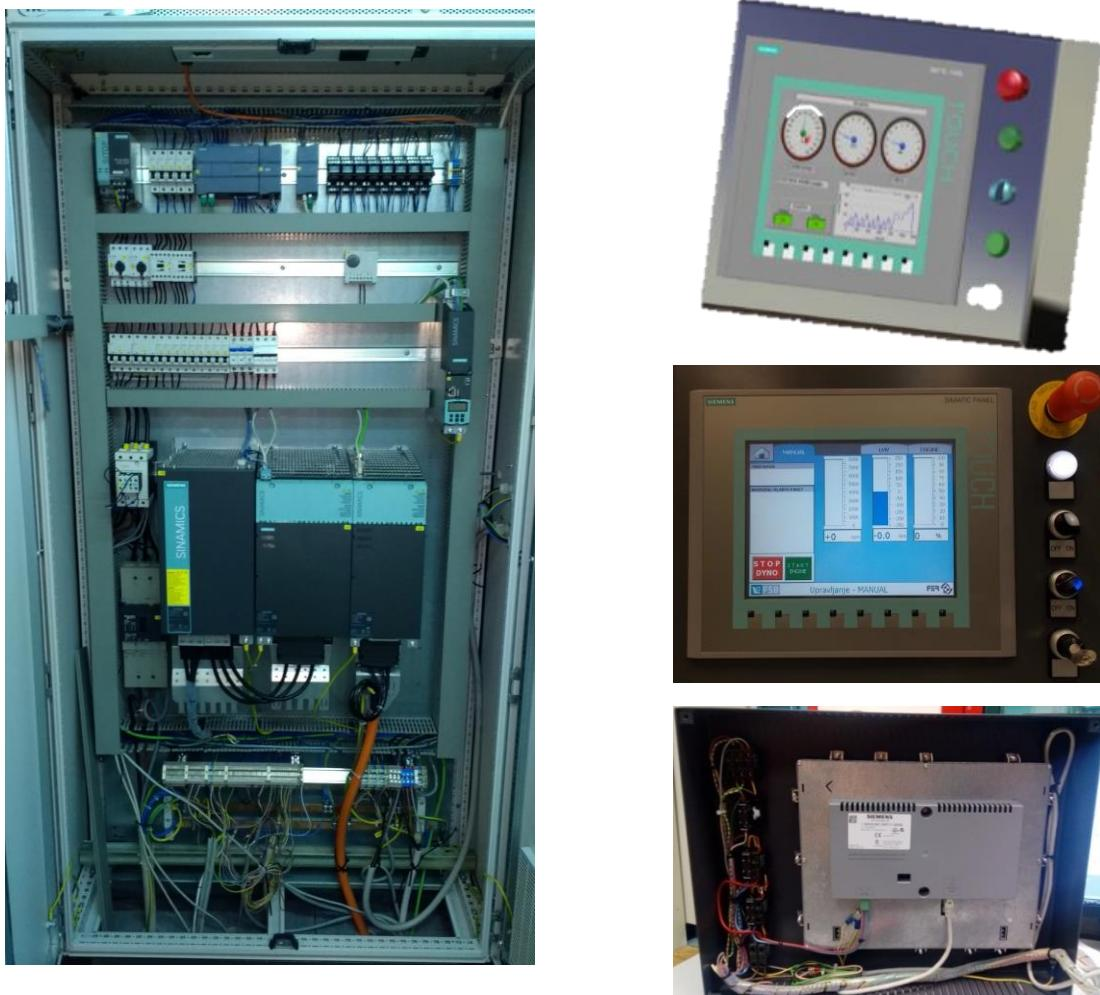
Slika 2.17. Upravljački ormar kočnice (lijevo) i HMI (desno)
