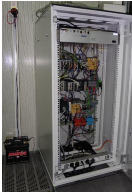
Slika 2.14. Ormar s elektroničkim komponentama za upravljanje radom motora
