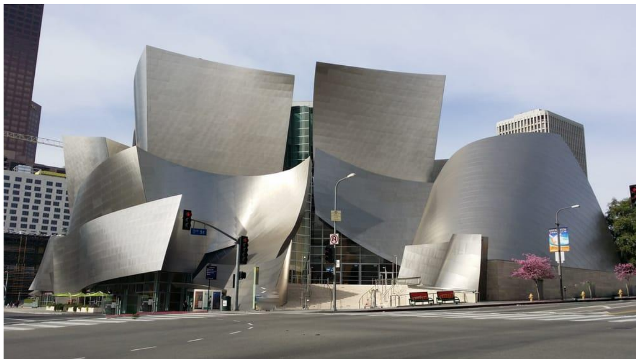
Slika 41. Građevina kompleksne geometrije izrađena pomoću virtualnih tehnologija
