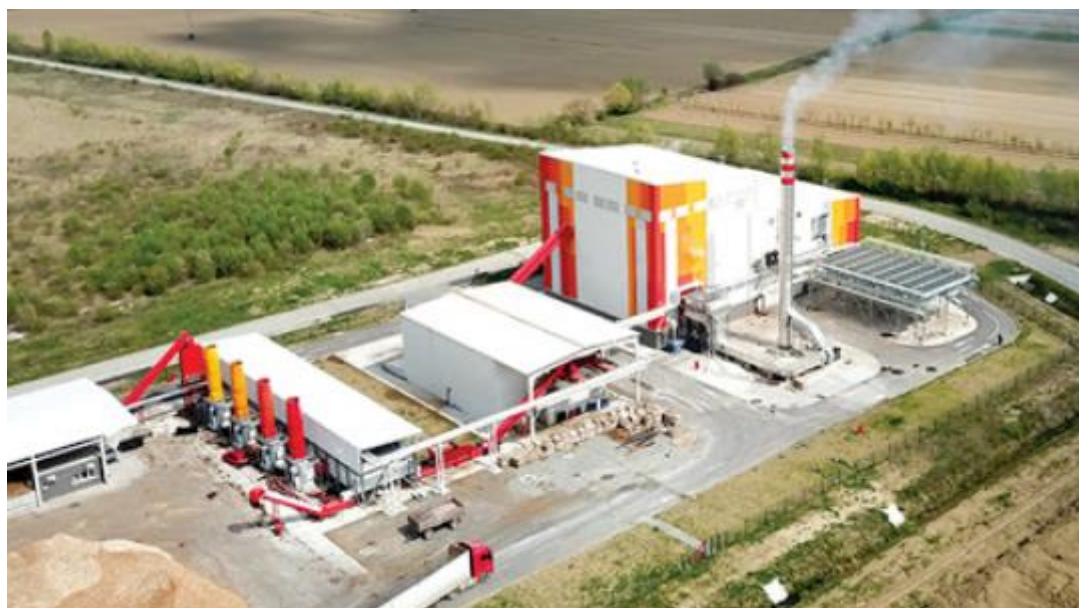
Slika 2.2. Kogeneracijska termoelektrana u Slatini
