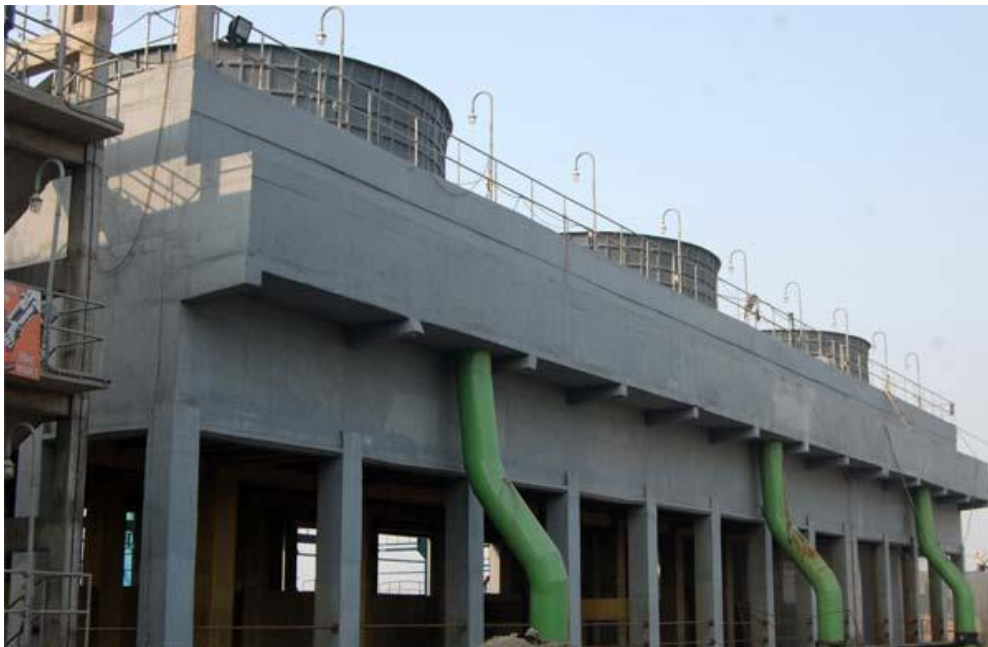
Slika 15. Betonski rashladni toranj
