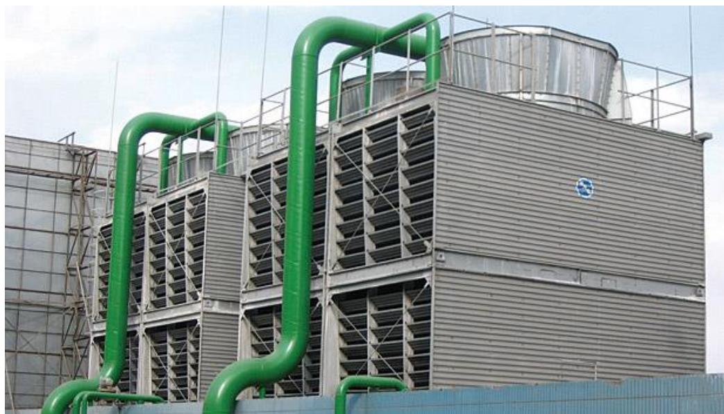
Slika 13. Rashladni toranj izrađen od galvaniziranog čelika
