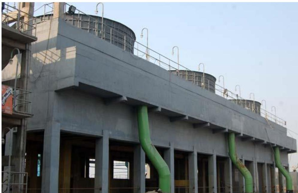
Slika 15. Betonski rashladni toranj
