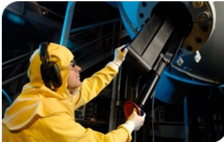
Slika 27. Unošenje Avera Rangera kroz otvor parogeneratora [19]
